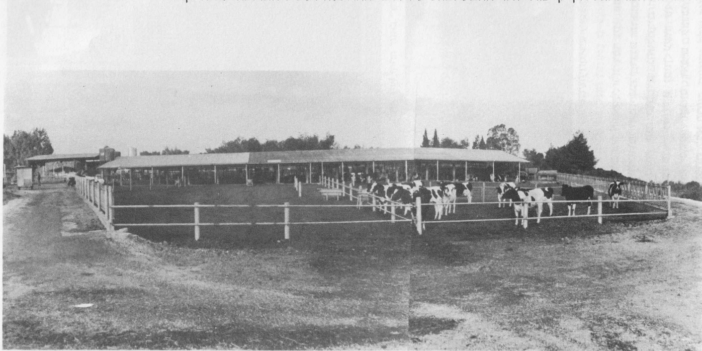
דברת (1975): סככת הרפד הישנה נמצאת בניצב לאיבוסים החדשים. החצרות הגדולות איפשרו הגדלת מספר המקומות. השיפוע הניכר בחצרות מבטיח ניקוז טבעי טוב, אפילו בלי רצפת בטון.
