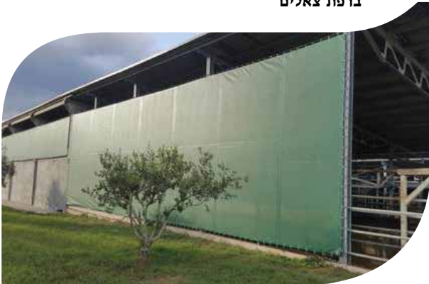
תמונה 8 - וילונות פלסטיים להצללה ומניעת חדירת קרינת שמש לחצר ההמתנה ברפת גדולה בדרום איטליה
