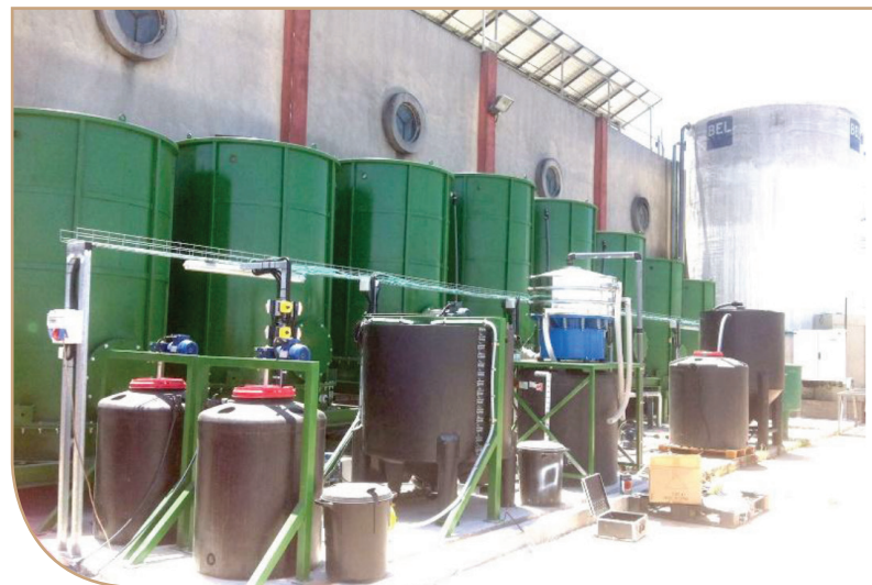
איור 1. מערכת משולבת מנגו-מורכבים לשיקוע מהיר של מוצקים מרחפים ותאים ביולוגים מאווררים. המערכת נמצאת ביקב דלתון ומביאה 20 מ"ק שפכים ביממה לאיכות הזרמה בלתי מוגבלת לרשת הביוב. תמונה באדיבות גאון מאמץ פולדמיר בע"ם.
