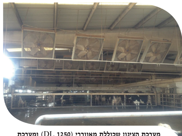
מערכת הצינון שכוללת מאווררי (DL 1250) ומערכת המטרה, כפי שפעלו בחצר ההמתנה בקיץ 201
