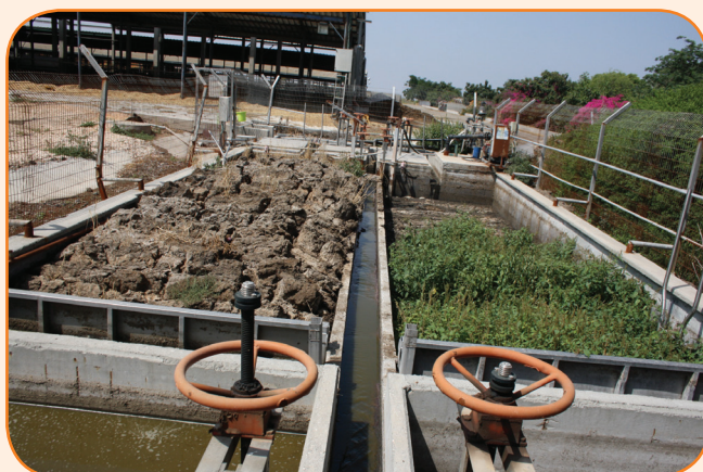
המתקן - שתי ברכות "חכמות" עם תעלה חיבור וגם בורות למחזור מים
