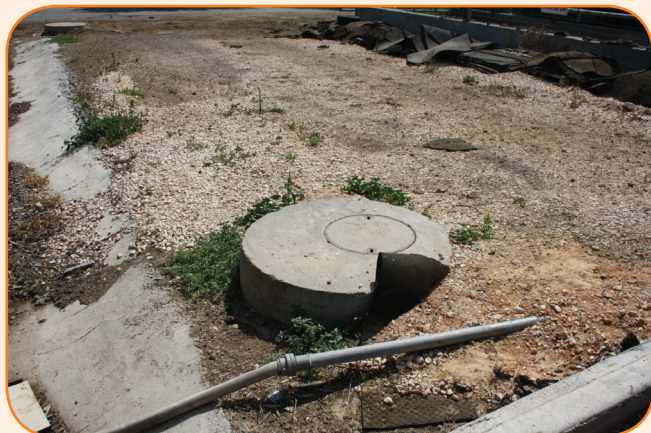
מי שטיפת המכון עוברים דרך ברכת ביוב לבורות המחזור
