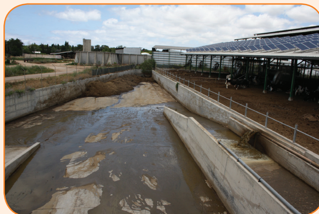
בור שיקוע אחרי ההפרדה שממנו השפכים נשלחים למתקן הביוגז
