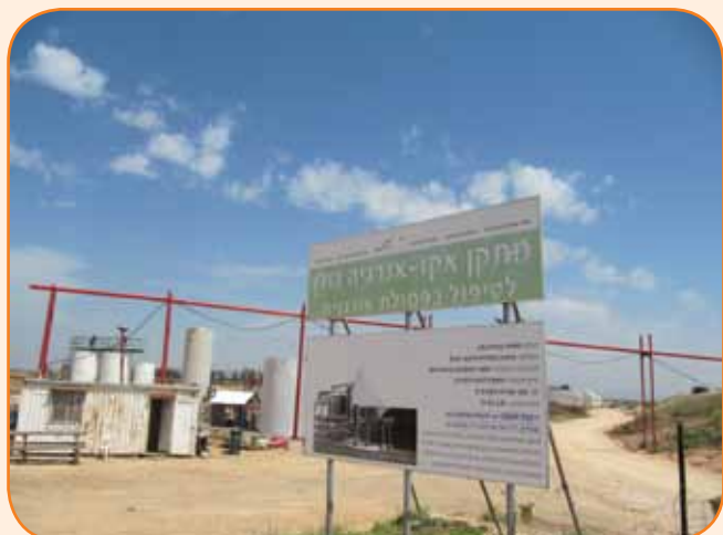
מתקן הביוגז בגולן בתהליך הבנייה
