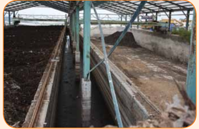
ברכת האגירה של השפכים לקראת פיזור על הזבל לשני הבורות
