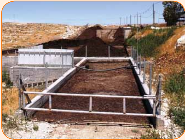
ברכות שיקוע השפכים - המים מספיק מסוננים לעבור בטפטוף
