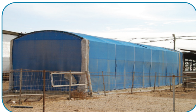
כיסוי הבור להפרדת מוצקים סטטי ברשת המונעת חדירת זבובים ברפת יהל
