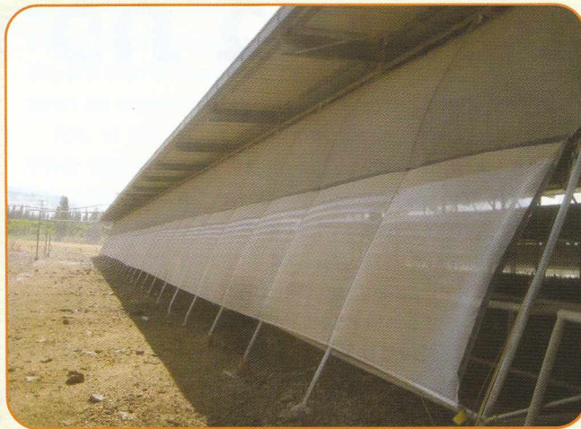
וילון חיצוני לאחר הורדה מלאה עם מנוע קטן ושרשרת
