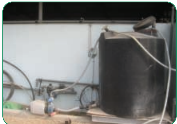
מכל צמוד למכון החליבה לאגירת מי השטיפה המחזורית-רפת "שביל החלב" בויתקין
