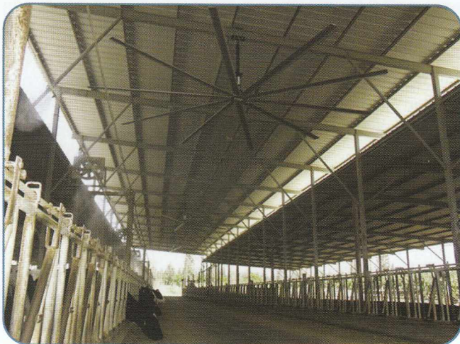
מערכת צינון באחת הסככות ברפת בית זרע. מערכת זאת כוללת מערכת ערפול וסחרור אוויר
