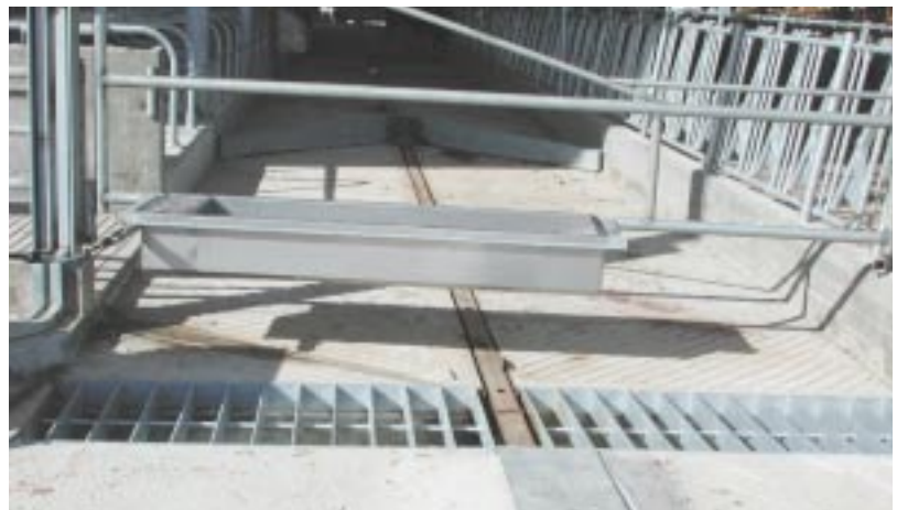
רפת מושבית - התעלה המאספת של הזבל ברפת הרובוטית של איתן גולן בכפר ויתקין
