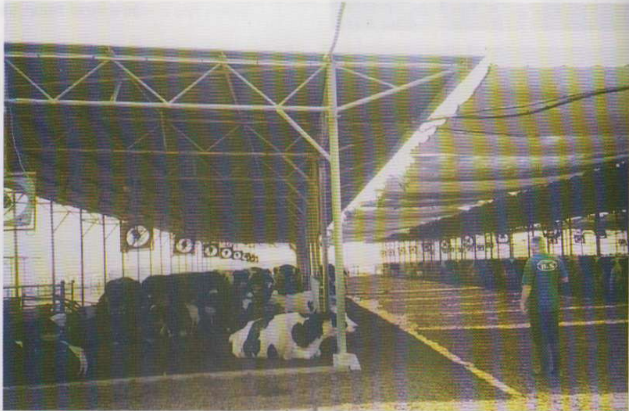
רשתות צל בחצרות הקוראלים+צינון עם עירפול בלחץ גבוה מבטיחים סביבה ומרבץ נח ויבש לפרות, גם בקיץ הלוהט.
