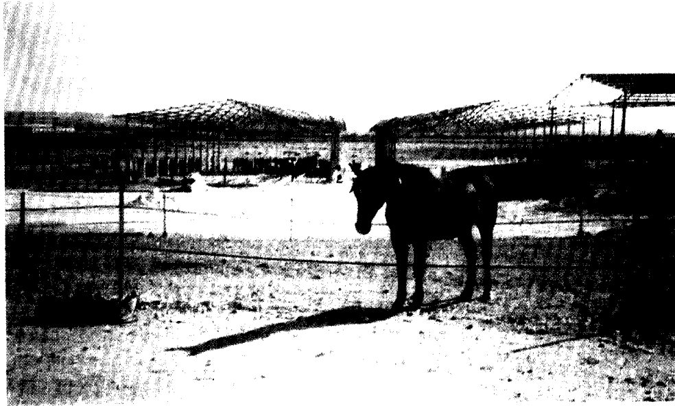
מראה הסככות בבניתן – שימוש חסכוני בקונסטרוקציות שפורקו ממקום אחר..
