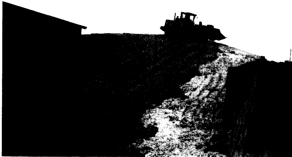
בור ראשון מלא, זוכה להידוק אחרון וכיסוי בקליפות הדורים בטרם אטימה.
