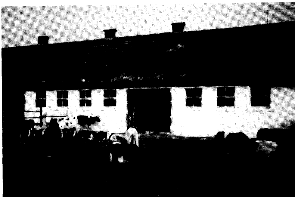
רפת מכוסה גג מקש, מרופדת היטב עבור עגלותינו.
