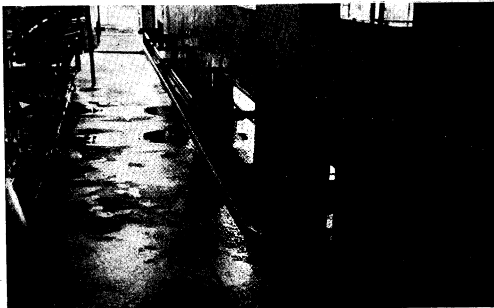
תמונה 1. צינור משתנה בעמדות שדרת-דג. הצינור מורד לחליבת מבכירות.
